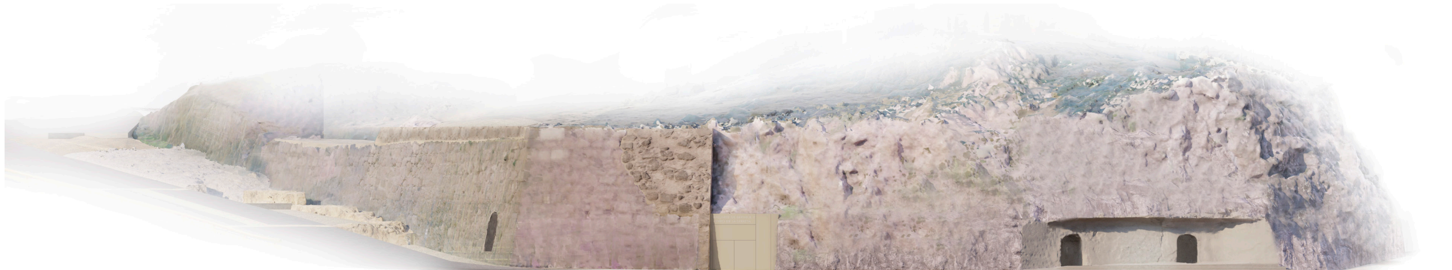
Alzado oeste de la muralla, Tras la actuación
